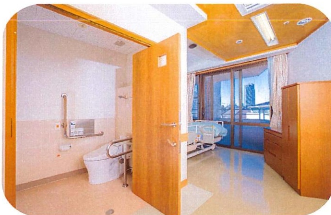
個室(壁紙貼り替え・トイレ扉・便器交換)
