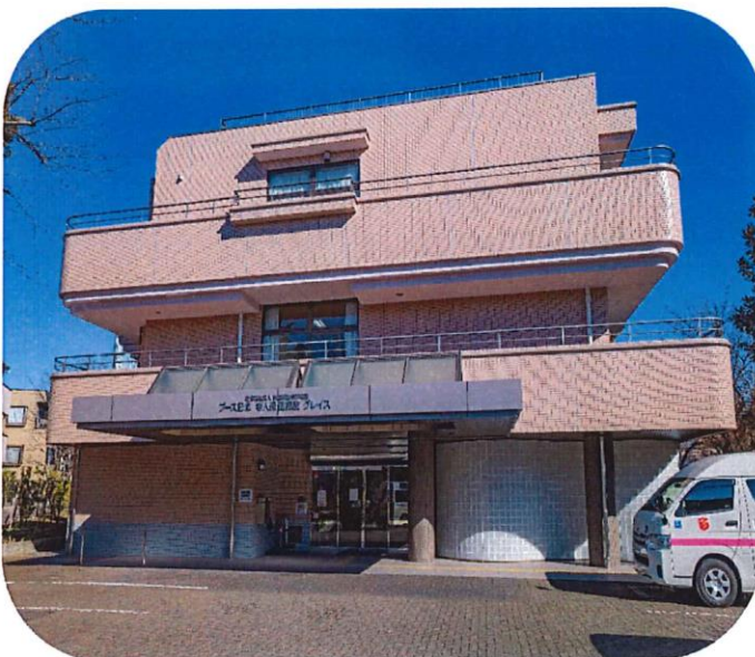
壁面(補修、洗浄)
