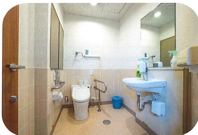
共用トイレ(壁・床面貼り替え、扉・便器交換)
